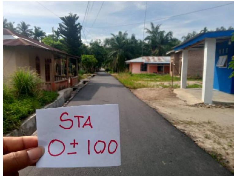
Gambar 3.2. Peningkatan Jalan Dusun X Pasar I Desa Simpang Gambus Kec. Lima Puluh
