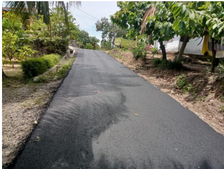
Gambar 3.1. Peningkatan Jalan Dusun VII menuju Balai Desa Perkebunan Lima Puluh Kec. Lima Puluh
