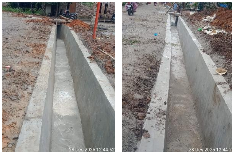
Gambar 3.11 Pembangunan Drainase di Dusun VII Desa Empat Negeri Kec. Datuk Lima Puluh
