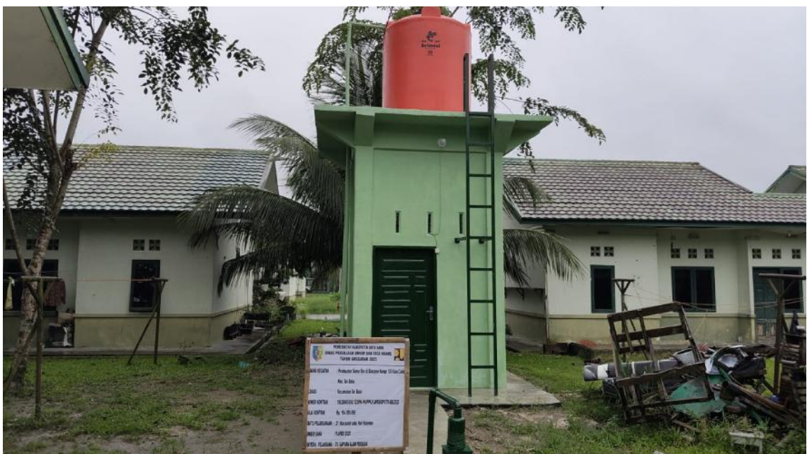
Gambar 3.6 Pembuatan Sumur Bor di Batalyon Kompi 126 Kala Cakti Kec. Sei Balai
